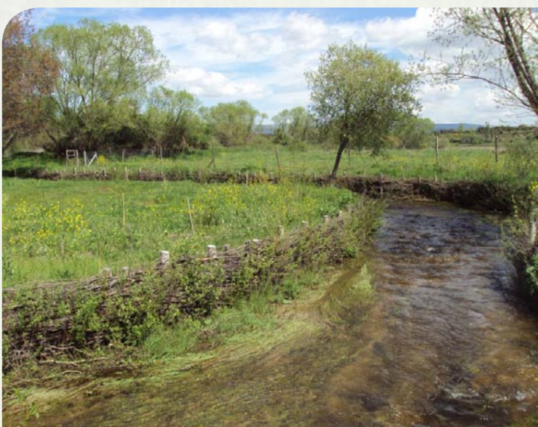
Empalizada trenzada en la actuación del arroyo Hija de Dios en La Hija de Dios, Ávila.
