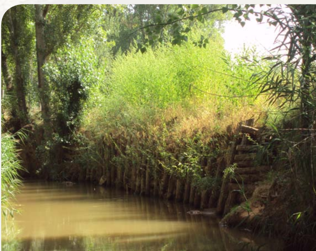
Empalizada de troncos en la actuación del río Turia en Villastar, Teruel.
